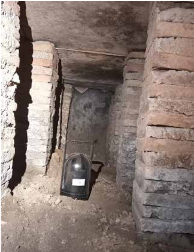
Figura 1 – Ambiente dell'ipocausto: pilastri di sostegno con in alto il pavimento della camera sovrastante; visibile nella foto lo strumento utilizzato, il BLK360 della Leica GeoSystem
